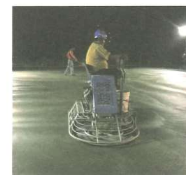
②粉光師傅操作坐騎式整體粉光機進行拍漿整平。
