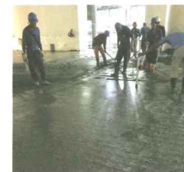
①樓地板混凝土澆灌完成後，進行初步整平工序。
