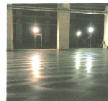
④混凝土經整體粉光處理後，最後呈現如鏡面般的平整表面。
