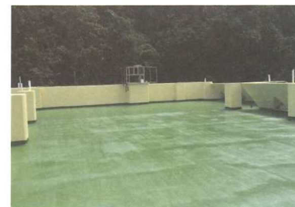
原校舍頂樓地面斑駁不堪；修繕後平整美觀，大幅改善長年漏水問題。
