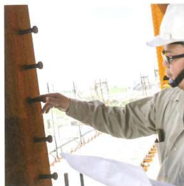
認真以待，確實檢查每處螺栓是否鎖牢。
