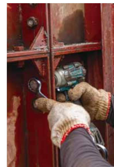
鋼模放置後，使用螺栓進行對鎖固定
