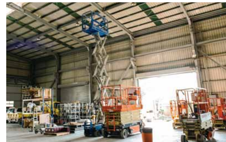
使用「高空自走車」施作屋頂鋼樑防火漆工程
