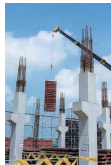
單面鋼模需以吊車吊掛輔助施工
