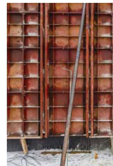
鋼模需使用特製鋼管斜撐進行地面支撐
