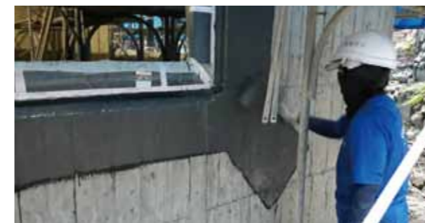
牆面開口最脆弱的45度剪力角，加做抗裂網補強
