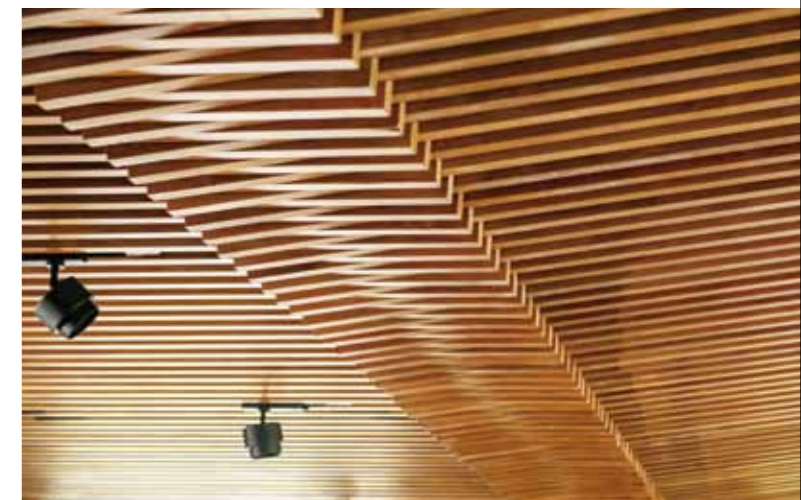
實木天花板，以交丁工法搭接排列而成
