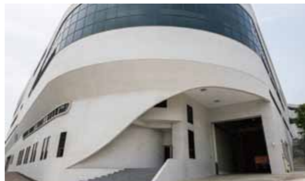
廠房外牆不規則曲面造型
