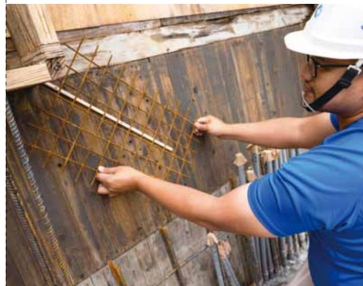
導裂溝與高密度鋼絲網的施作位置
