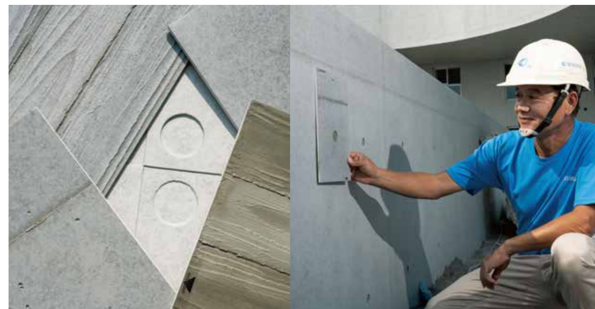
SA工法承包施作廠商，會提供標準樣板及現場試做樣板，可做為施工驗收的顏色比對憑證
